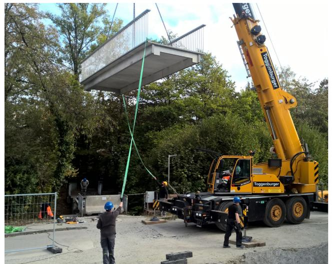
Komplett mit Geländer wurde die Brücke mit dem Tieflader vom Werk geliefert und mit einem Pneuroman auf die vorbereiteten Auflager aufgesetzt.
