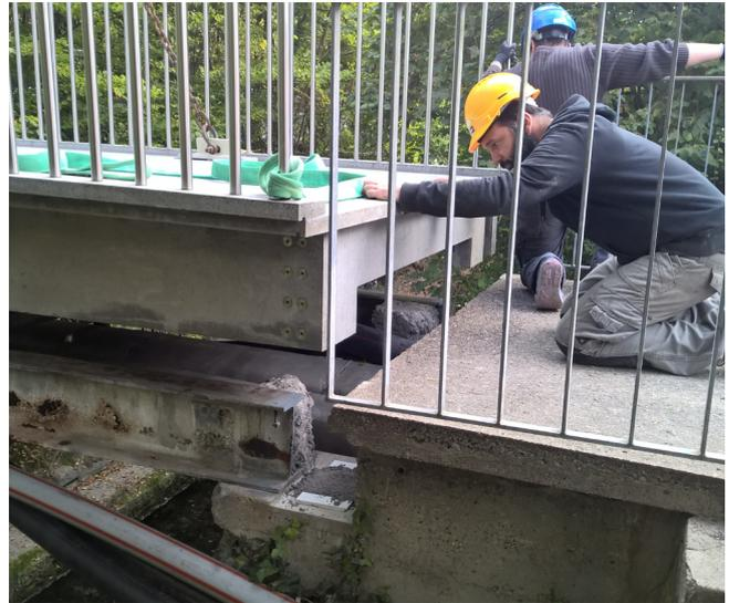
Blickfang ist das Brückengeländer, bestehend aus Chromstahlstaketen mit einem darüber liegendem CPC-Handlauf. Im Zuge der Sanierung konnte die Geländerhöhe auch den gültigen Normen entsprechend, auf eine Höhe von 1.10 m, angepasst werden.
