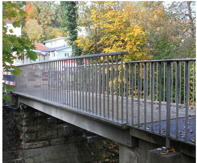
Das neue Geländer ist fein auf die Brückenkonstruktion abgestimmt. Die Staketen aus Chromstahl werden von einem verklebten Randstreifen und Tragen einen schlichten Handlauf. Beide sind ebenfalls aus carbonbewehrten CPC-Platten gefertigt.
