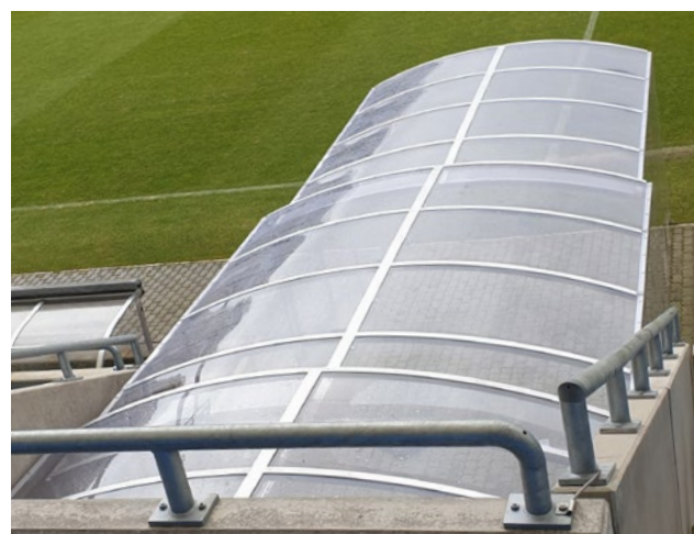
Tunnel d'accès pour joueurs „Strong“
