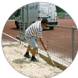
Travaux de préparation
