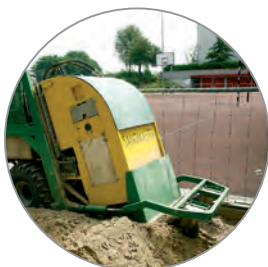
Nettoyage en profondeur jusqu'à 40 cm
