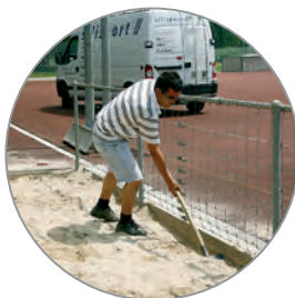
Travaux de préparation
