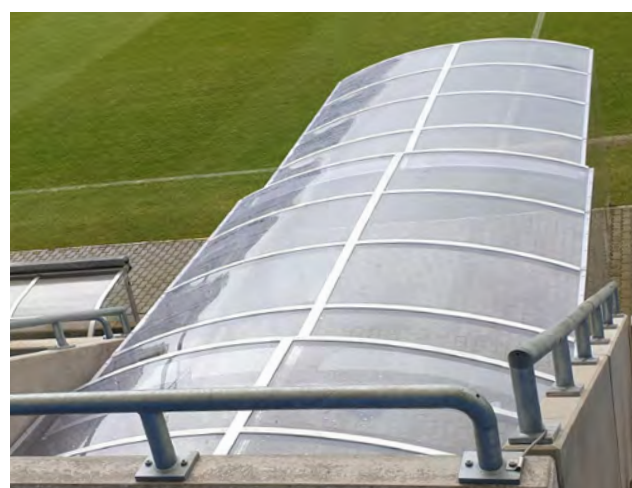
Tunnel d'accès pour joueurs „Strong“
