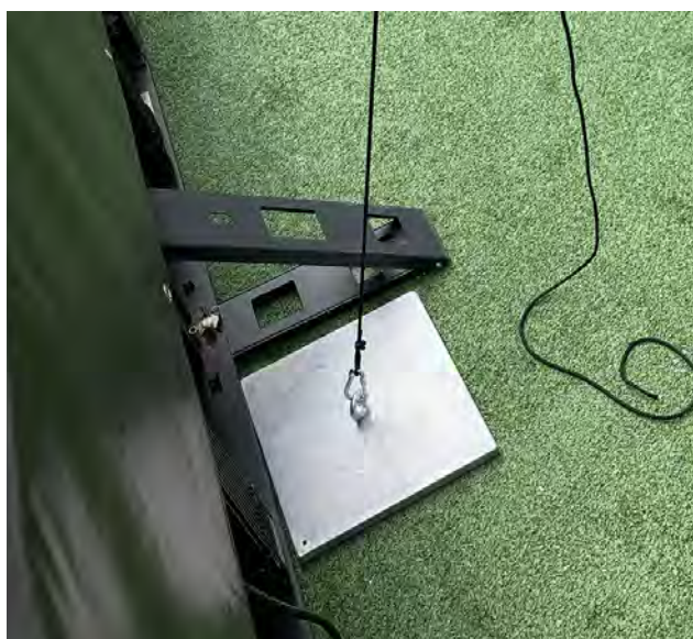
Stahlplatte zur Netzbeschwerung
