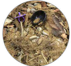
Verunreinigungen/Abfall (Entsorgung bauseits)
